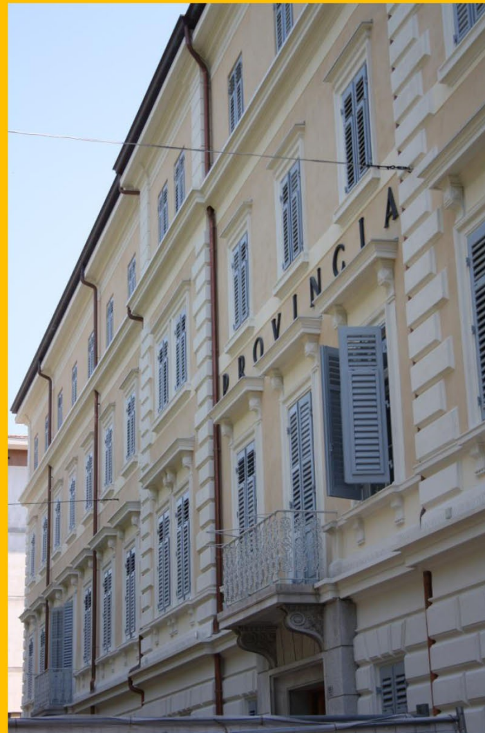
Lo stesso prospetto dopo il restauro dei serramenti, degli intonaci e della copertura
