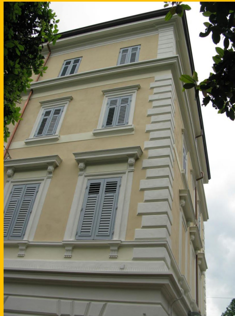
Lo stesso prospetto dopo il restauro dei serramenti, degli intonaci e della copertura
