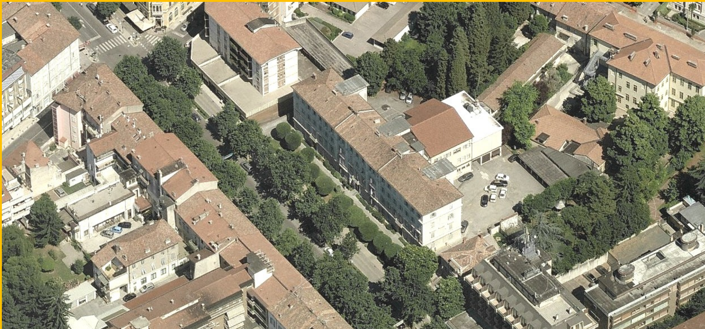
Il Palazzo prima dell'inizio dei lavori nel contesto urbano di Gorizia, Corso Italia.
