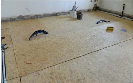
Posa dei sottoservizi, posa del tavolato OSB, posa dei connettori.
