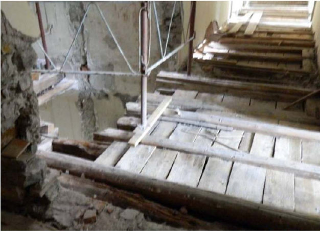
Ripristino delle zone corrispondenti all'ascensore preesistente, trattamento antitarlo, ricostruzione delle lacune con resine.
