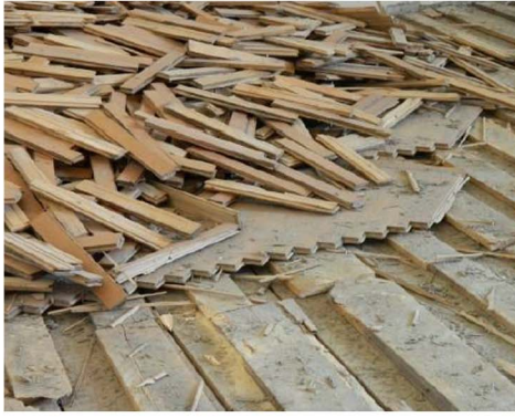
Rimozione e recupero dei listoni in rovere, apertura dei tavolati superiori e stratificazione sopratravi, svuotamento dei riempimenti di terra.
