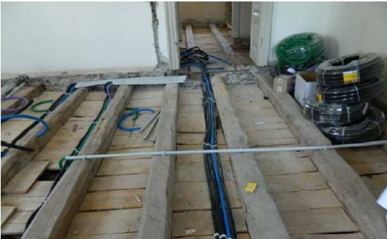
Posa dei sottoservizi, posa del tavolato OSB, posa dei connettori.
