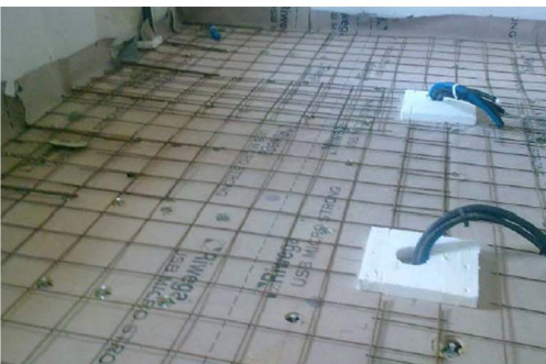
Posa delle reti e delle connessioni alle murature, getto del primo e del secondo massetto.
