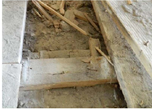
Rimozione e recupero dei listoni in rovere, apertura dei tavolati superiori e stratificazione sopratravi, svuotamento dei riempimenti di terra.
