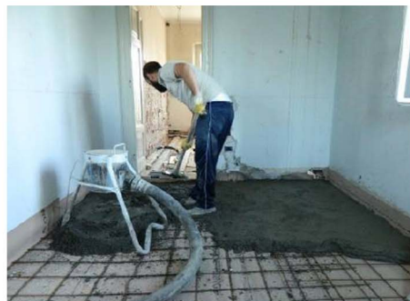
Posa delle reti e delle connessioni alle murature, getto del primo e del secondo massetto.
