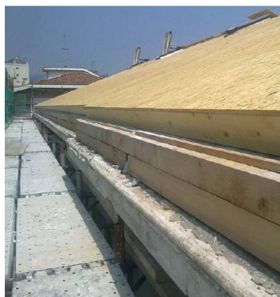
Posa del pacchetto di sottomanto, posa dei listelli di sottogronda, posa della membrana ardesiata e del manto in coppi.
