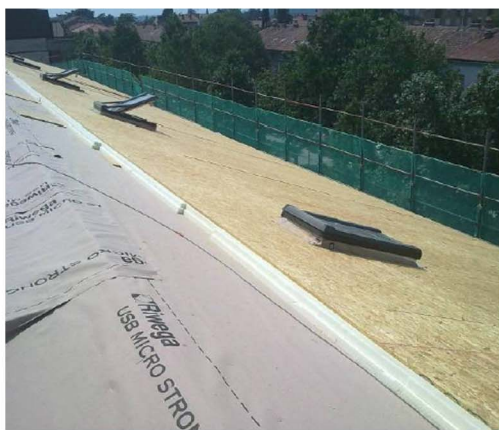
Posa del pacchetto di sottomanto, posa dei listelli di sottogronda, posa della membrana ardesiata e del manto in coppi.
