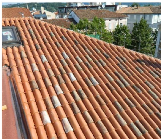
Nuovi lucernari lato corte, manto con coppi di recupero, linea-vita.
