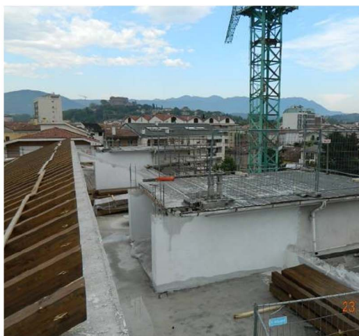
Getto del cordolo di colmo, posa della nuova struttura, posa del tavolato.
