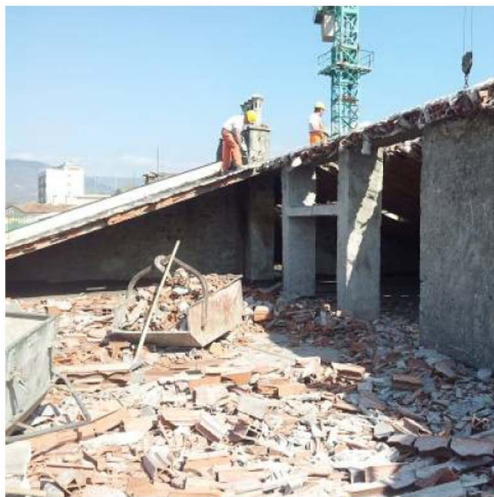
Demolizione, rimozione delle tavelle interne al cornicione, getto del cordolo perimetrale.
