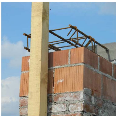
Getto del cordolo di colmo, posa della nuova struttura, posa del tavolato.
